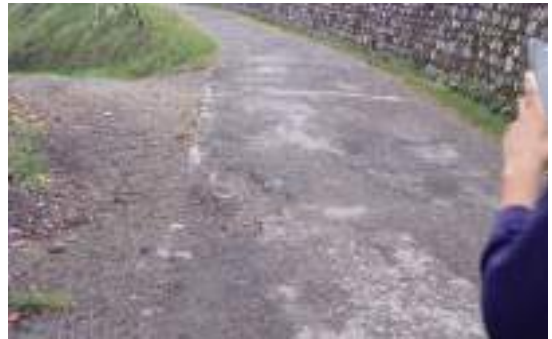
Fig. 4. Edge cracking
